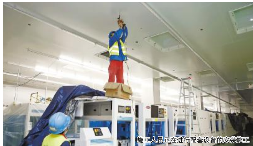
施工人员正在进行配套设备的安装调试
