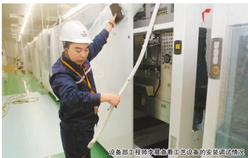
设备部工程师李晨查看工艺设备的安装调试情况
