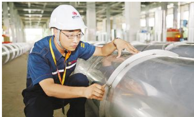
黄建军在 S2 车间在建项目现场查看有机排风管道是否符合技术要求
