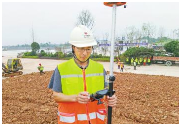
张凌用GPS测量绿化土方
