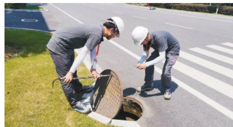
合肥基地员工排查排水通道
