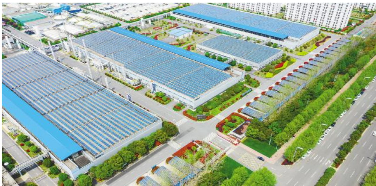
通威太阳能合肥基地绿色厂区
