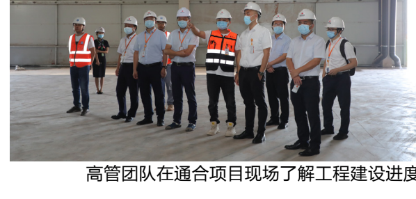
高管团队在通合项目现场了解工程建设进度
