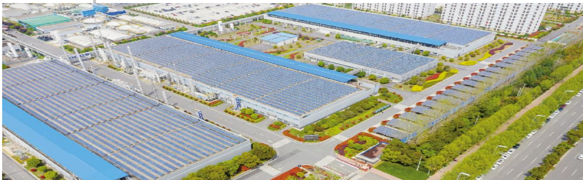
通威太阳能合肥基地
